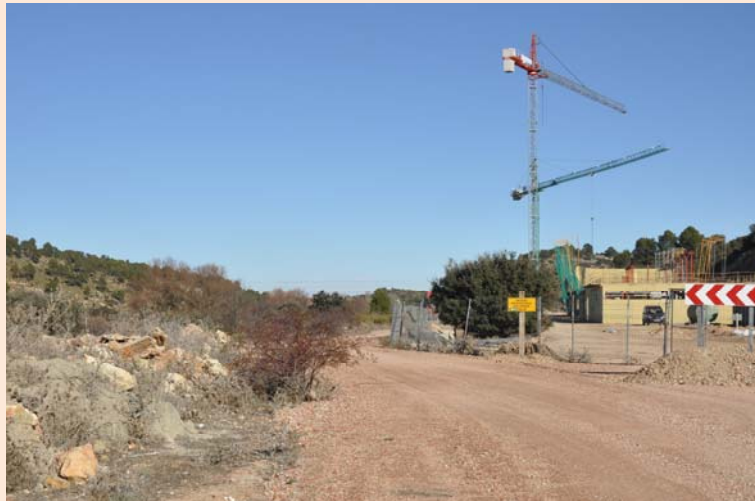
Revisión del estado general de las obras
